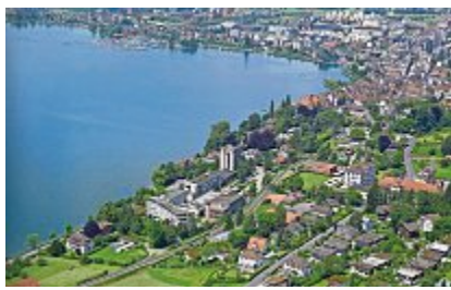
Das Areal des ehemaligen Kantonsspital soll weiterentwickelt werden. z.v.g.
